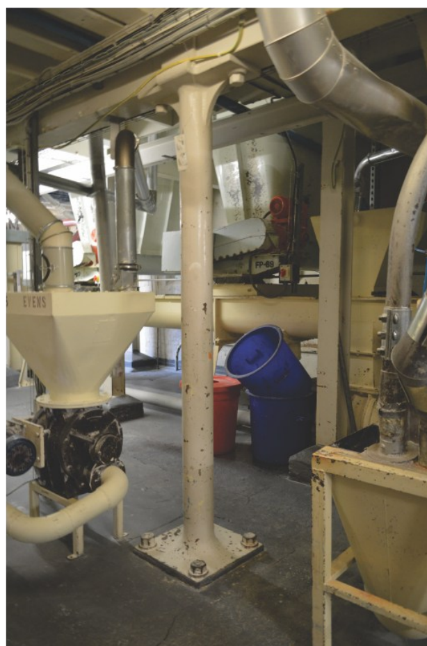
Pl. 36 First-floor column 2017 (N. Field)
