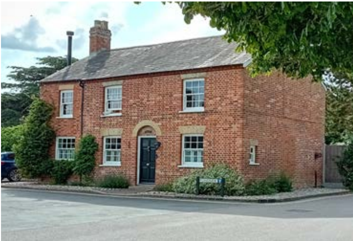
Voussoir headers. Brick detailing denotes door
